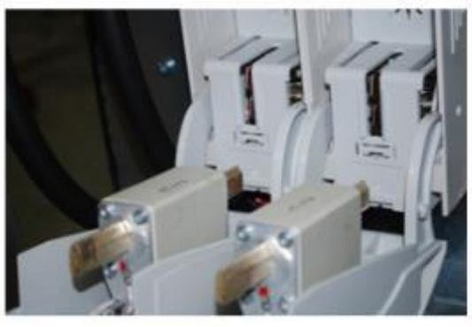
*Abbildung Darstellung der korrekt eingelegten Sicherungen*
